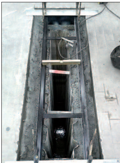
Ausrichtung für Betonierung des neuen Rahmens
