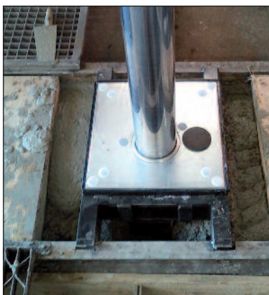
Einbetonieren des neuen Rahmens
