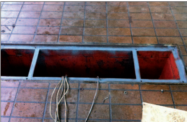
Überarbeitung des Kassettenrahmens
