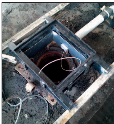
Ausrichtung und Verschalung des neuen Rahmens
